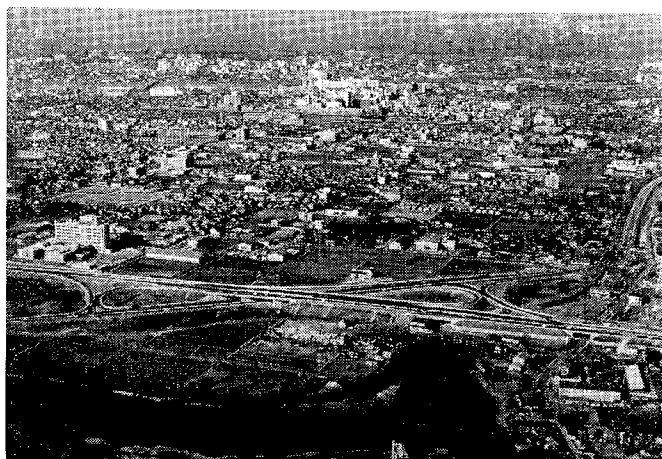
新潟バイパス紫竹山 インターチェンジ付近
