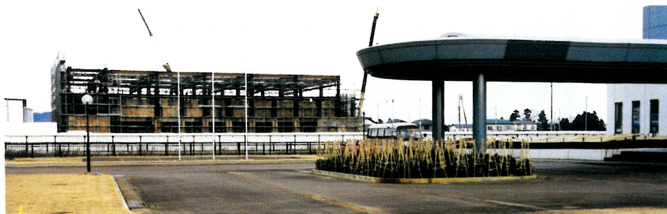
建築中の事務センター(平成9年12月20日)
