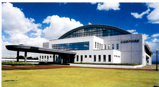
完成した北越銀行体育館
