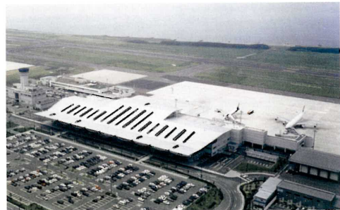
新装なった新潟空港旅客ターミナルと2,500m滑走路
