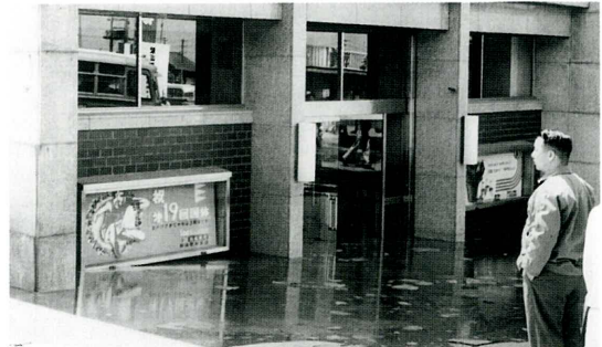
新潟地震で沈下・傾いた新潟駅前支店
