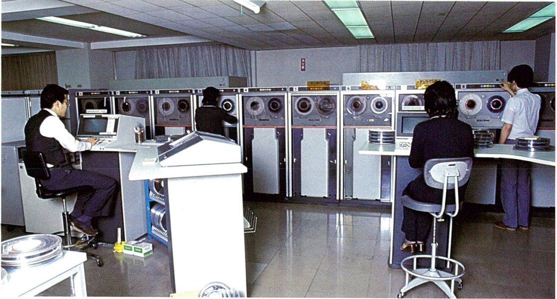
各種データを集積処理するコンピュータ室
